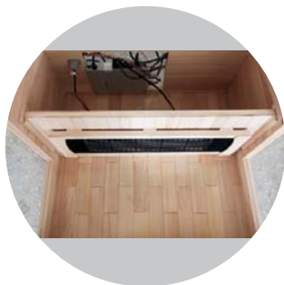
Umístění části lavice do drážek
